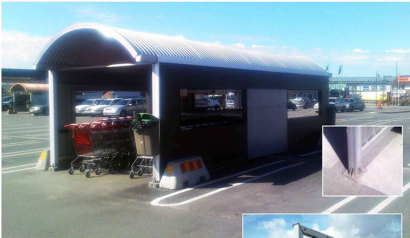
Fundament till skärmtak vid Ingelsta köpcentrum i Norrköping.
